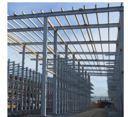
Kragarmregal als Statik für einen Hallenbau.
