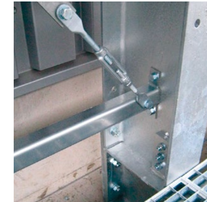
Ständerverbindungen immer in verzinkter Ausführung.
